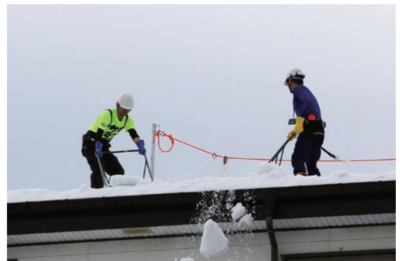
命綱、ヘルメットを着装して作業をする様子
