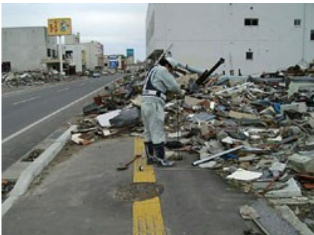
水道復旧作業の様子(大船渡市)
