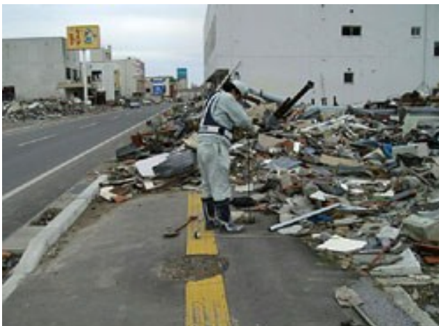
水道復旧作業の様子(大船渡市)
