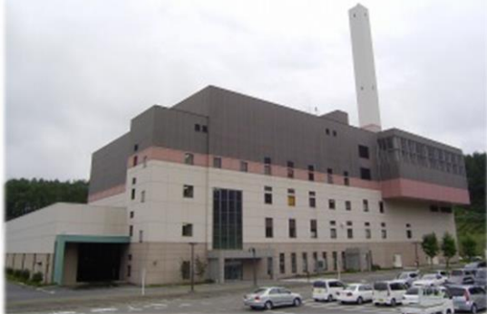
盛岡市クリーンセンター
