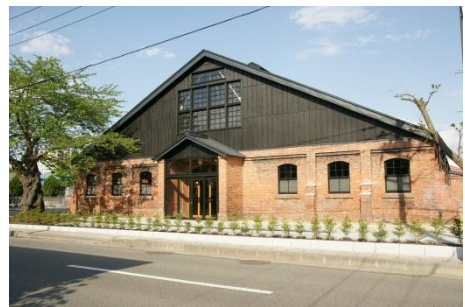
平成 24 年 6 月に開館し、景観重要建造物第 1 号に指定した盛岡ふれあい覆馬場プラザ
