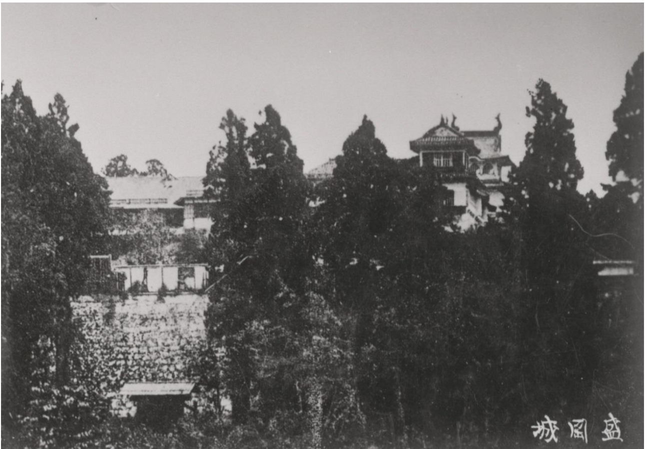
写真 29 明治7年の建物解体と樹木伐採前の盛岡城(西から・もりおか歴史文化館蔵)
