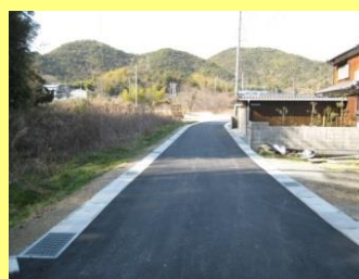
生活道路整備
