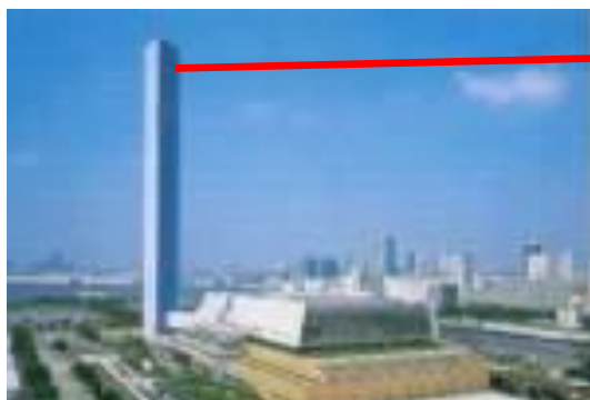
■中央清掃工場(中央区)
