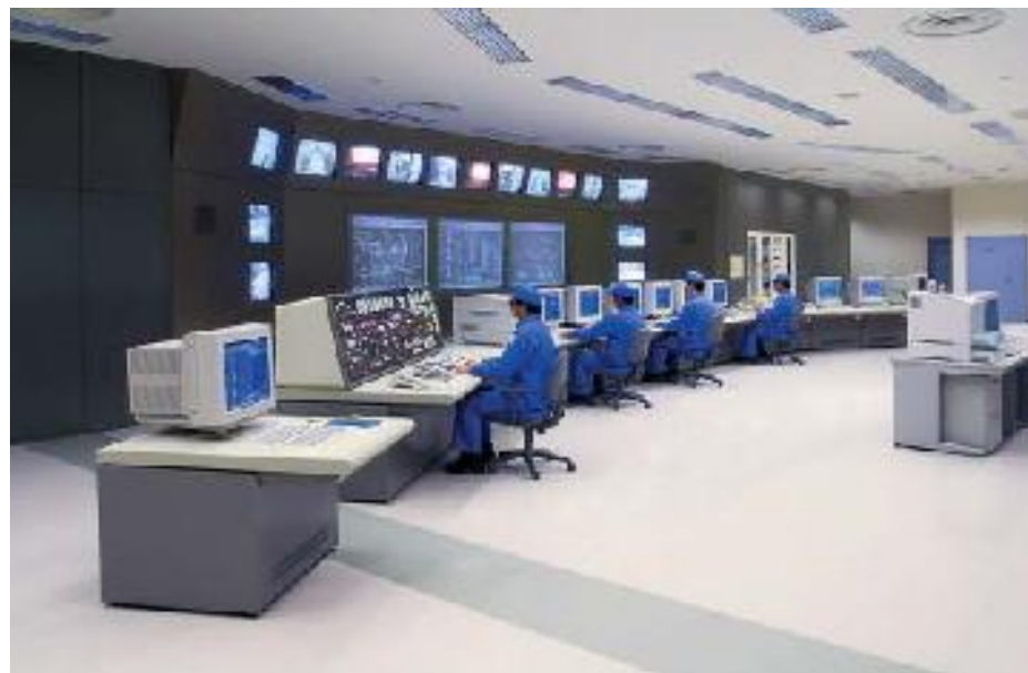
ごみ焼却施設の中央制御室
