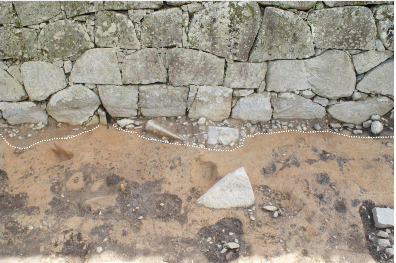
三ノ丸北面石垣（中央） 根石据方掘りこみ
