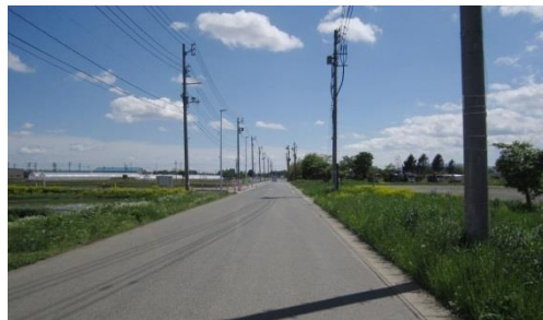
②東側道路北側から南方向を望む
