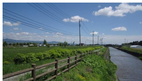
⑨西側道路を南南東方向を望む
