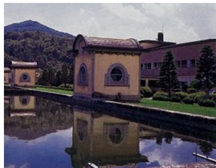
米内浄水場（緩速ろ過池）
