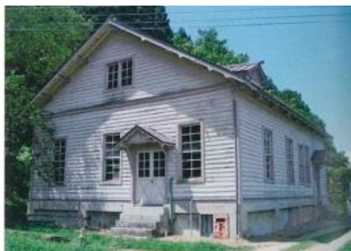
旧宇津野発電所
