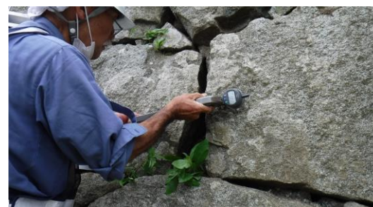
石垣変位調査状況
