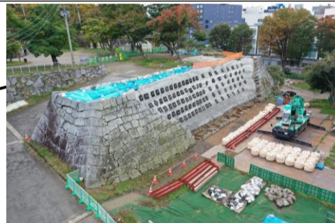
三ノ丸北西部石垣
