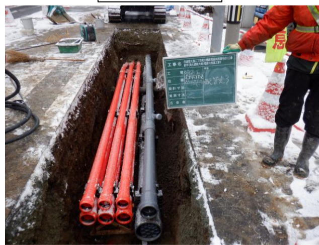
管路部施工状況
