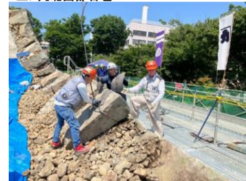
三ノ丸北西部石垣解体作業の状況
