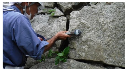
石垣変位調査状況
