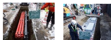
電線共同溝工事の状況
