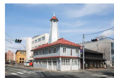
整備後の紺屋町番屋
