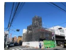
景観重要建造物の改修
