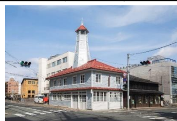
紺屋町番屋改修完了R3.11
