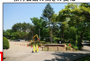
史跡盛岡城跡内の樹木伐採
