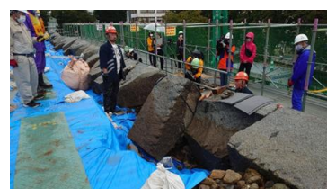
石垣修復工事の様子
