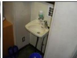
5 水返しのないウェット仕様のシンク。下処理室が区画できず下処理作業（汚染区域）が調理室内（非汚染区域）での作業となっている。
