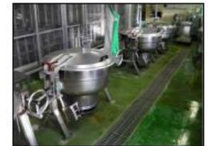
7 回転釜の排水が床面に流れドライ運搬に不達。
