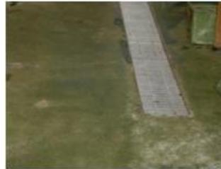
・ グレーチング・側溝周りの劣化。(錆・変形)
