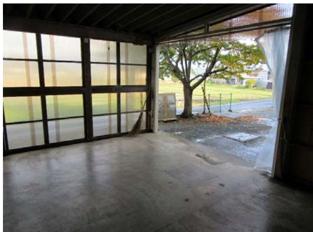
⑤ 1Fコンテナ室
