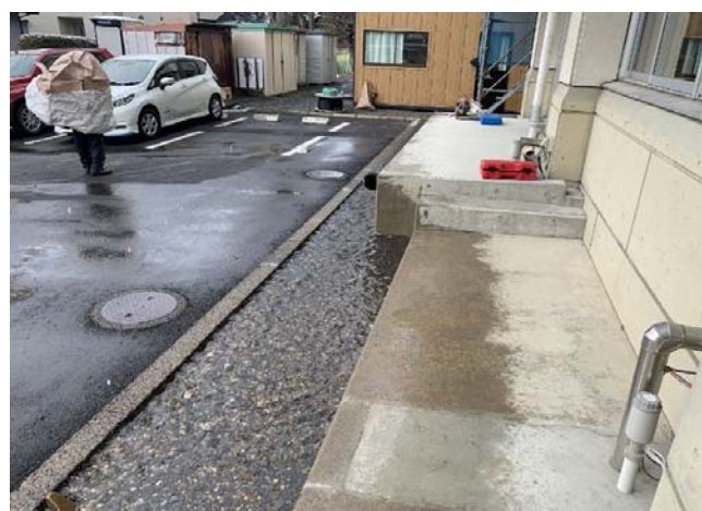
⑤ 1F配膳室 プラットホーム
