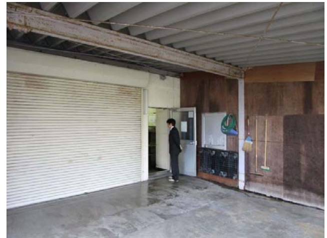
④ 1Fコンテナ室
