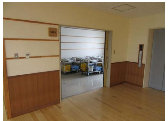
⑥ 1F配膳室シャッター
