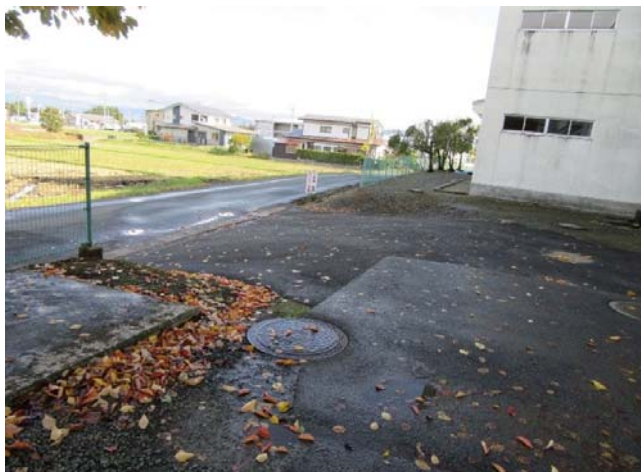
⑦ 屋外スロープ ※降雪時等、スロープの上り下りが困難
