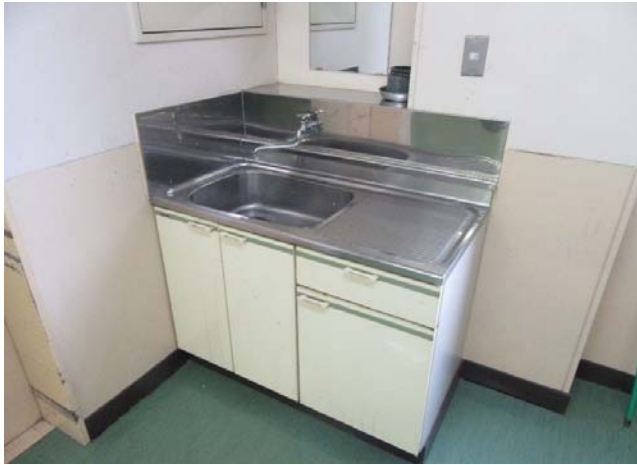
⑦ 2F配膳室 流し台
