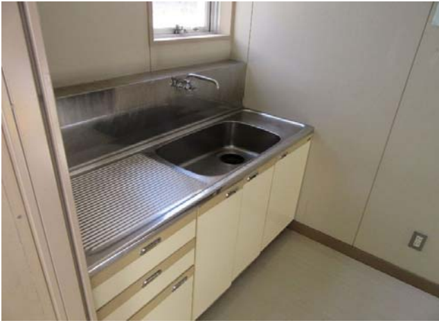
⑦ 2F配膳室 流し台
