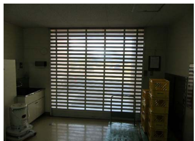
⑥ 1F配膳室シャッター
