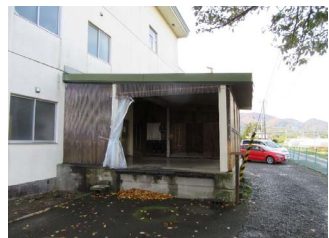
⑥ 1Fコンテナ室
