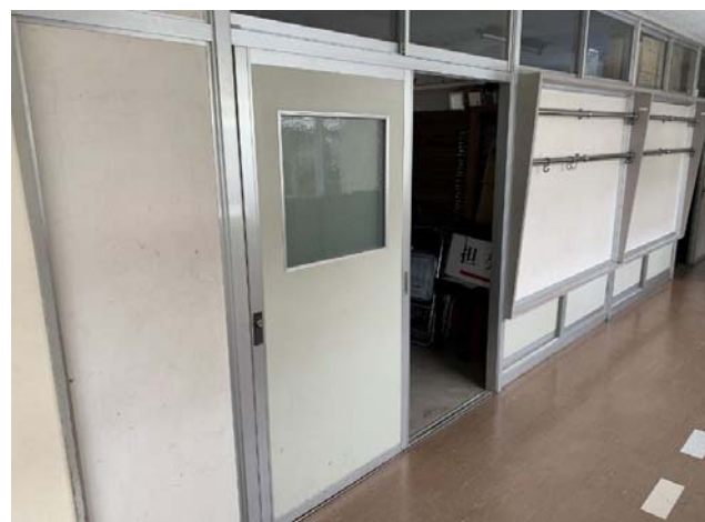
④ 1F配膳室 入口部
