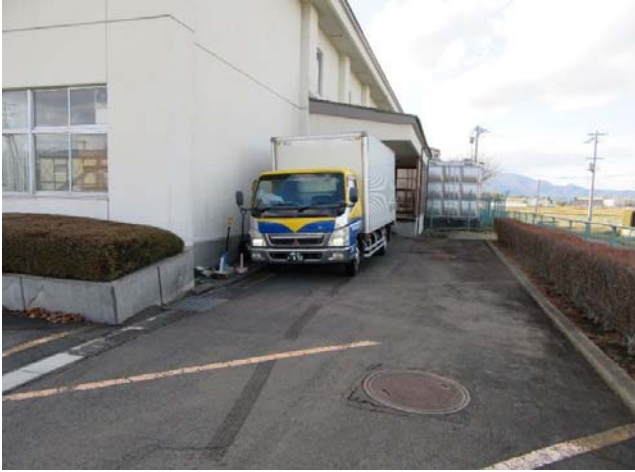
⑦ 屋外搬入スペース ※傾斜があり、台木を使用し調整
