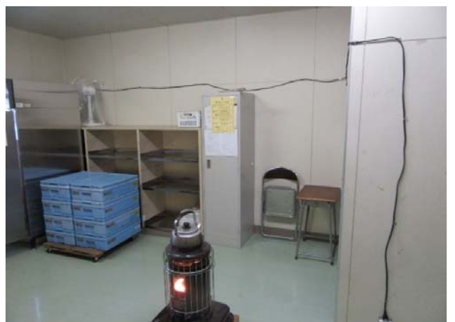
⑥ 1F配膳室 ※冷蔵庫への露出配線
