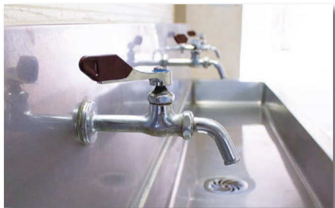
蛇口の変更で新型コロナウイルス感染症対策を強化 (市内施設の水道蛇口をハンドル型からレバー式に変更)
