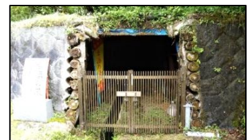
大萱生金山・万寿坑
