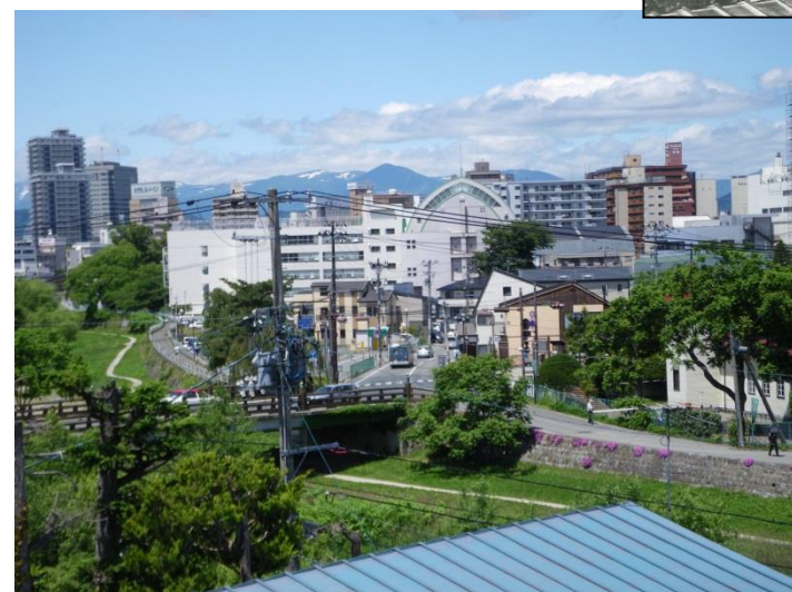
（平成 21(2009)年） 「下の橋」付近
