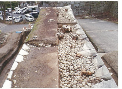
瓦門北側石垣 栗石検出状況
