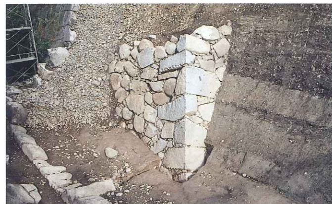
盛岡城1期の石垣（本丸南西部地下）
