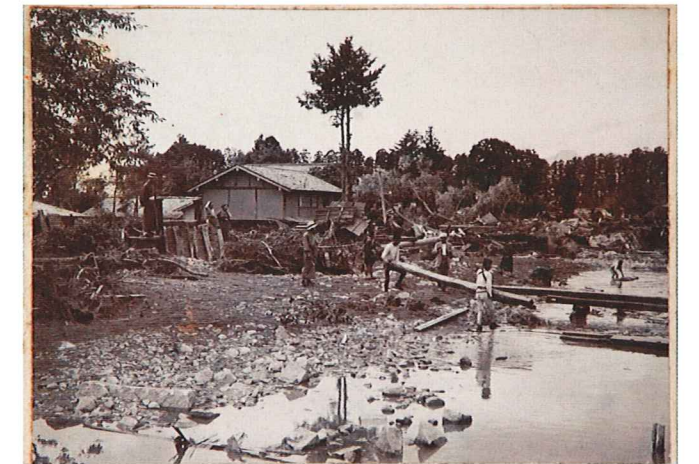
「岩手公園より下の橋附近」 家屋材を利用して仮橋を架設している様子
