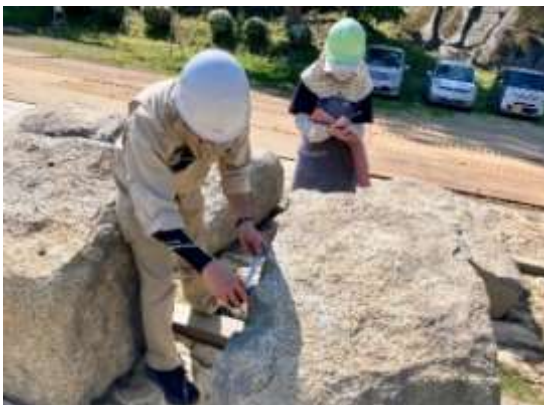
▲ 令和4年度の石垣解体の様子
