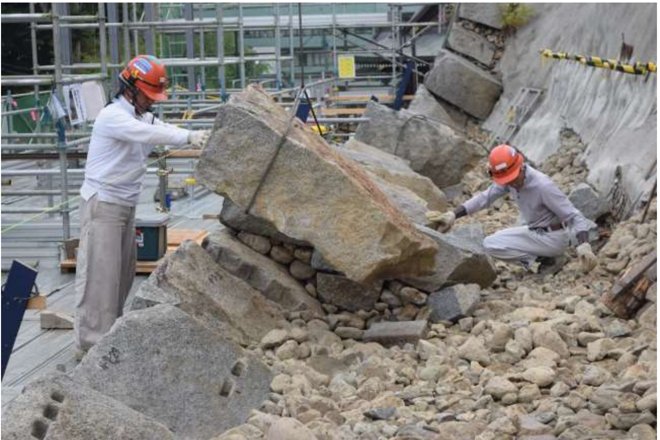
令和6年度の積み上げの様子
