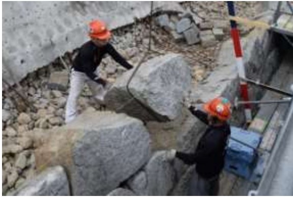
▲ 築石を積み上げる様子
