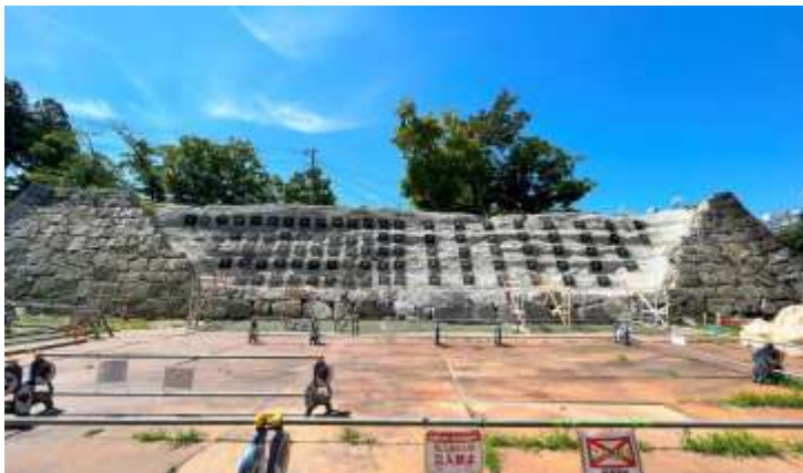
解体完了状況
