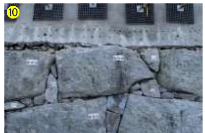
積み上げ完了
