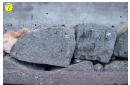
設置後（正面から）
