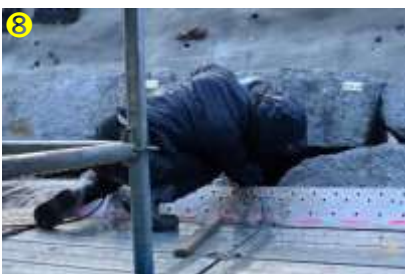
正面の隙間から栗石を詰める
