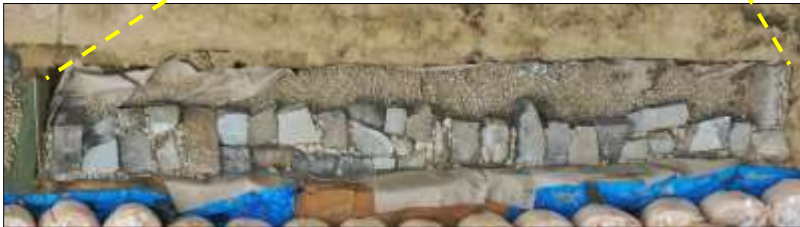
上：押え石残存状況 下：押え石再現状況
