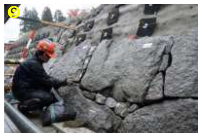
正面から間詰石を詰める
