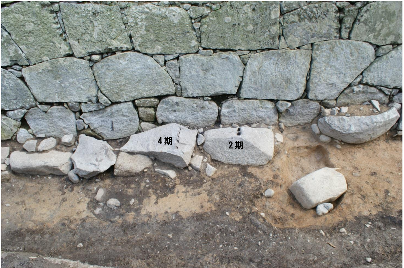
三ノ丸北面石垣（東） 矢穴の残る根固石
