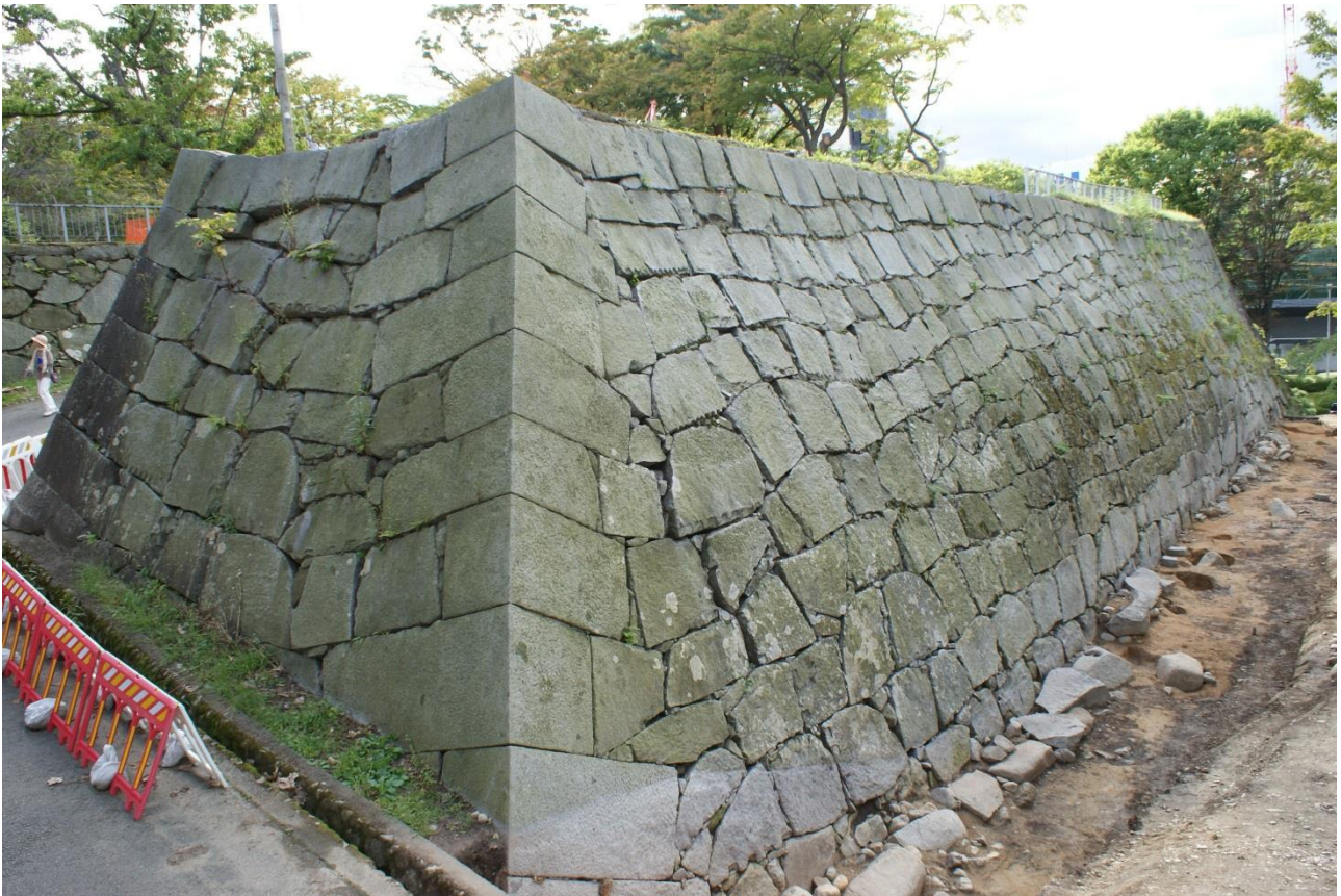
三ノ丸北西部北面石垣 全景
