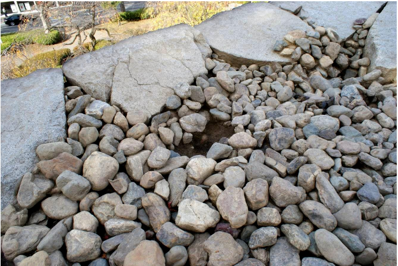
三ノ丸北西部上面 控柱跡①検出状況
