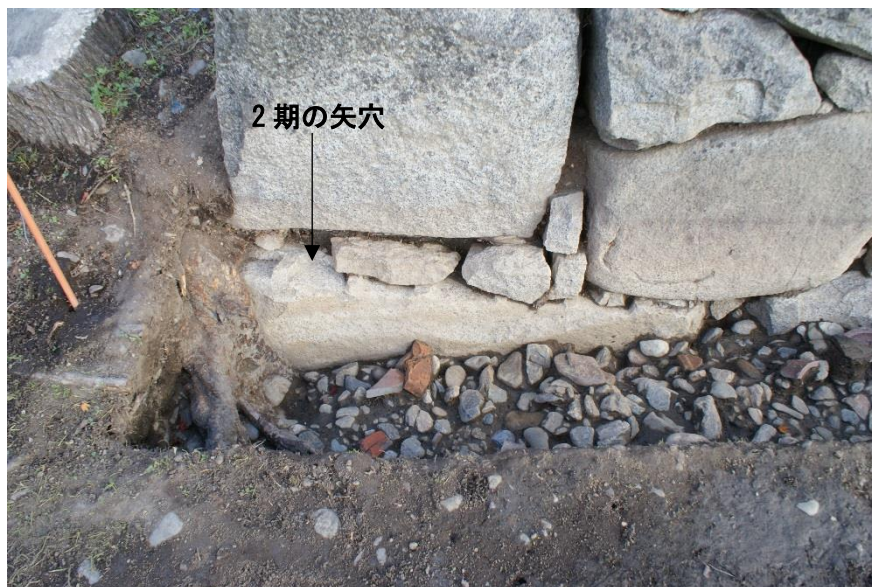
天守台北西隅根石（手前の礫群は根石を押える栗石）
