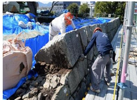
② 下の築石との間にキャンバー（くさび）を差し込みます。
