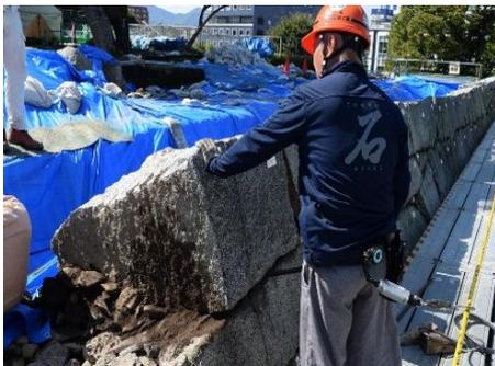
① 築石のすき間にバールを差し込み、部分的に持ち上げます。
