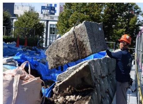
④ クレーンで吊り上げ、ダンプカーや仮置き場に降ろします。
