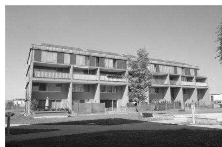
CLT建造物(海外)
