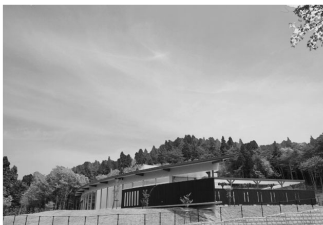
山形県の耐火柱メーカー(株)シェルターが建築した大規模模木造建築「紫波町火葬場」
