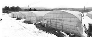
松川発電所では、花や野菜のハウスへ温水を供給
