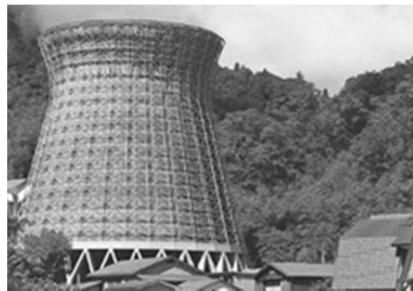
松川地熱発電所
