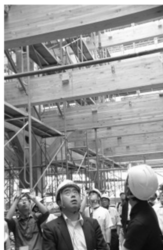
建設中の紫波町庁舎
