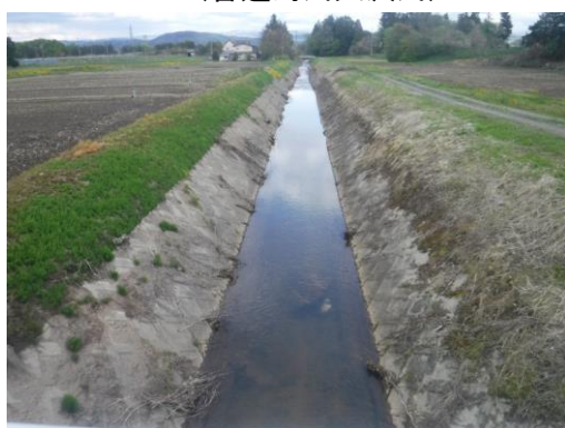
コンクリートブロック張護岸 (普通河川湯沢川)
