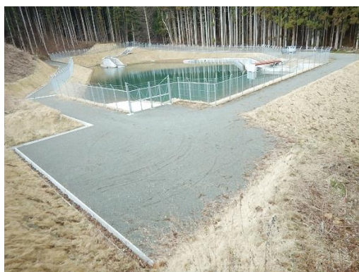
大沢川沈砂池
