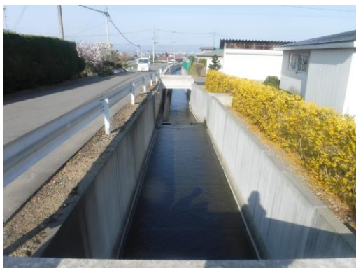
コンクリート護岸 (普通河川大沢川)
