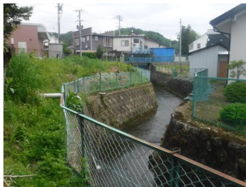
コンクリートブロック積護岸 (準用河川白滝川)
