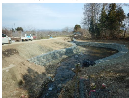
かご工護岸 (準用河川木伏川)
