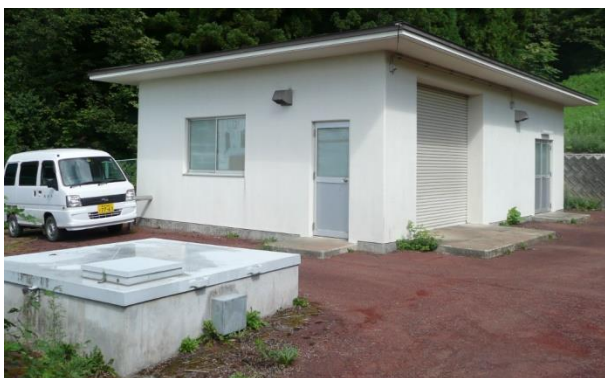
浄水棟と取水 1 号
