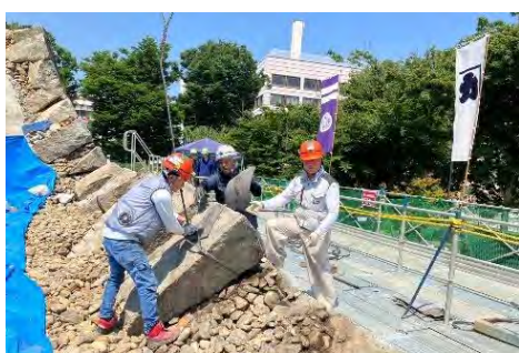
石垣解体の様子
