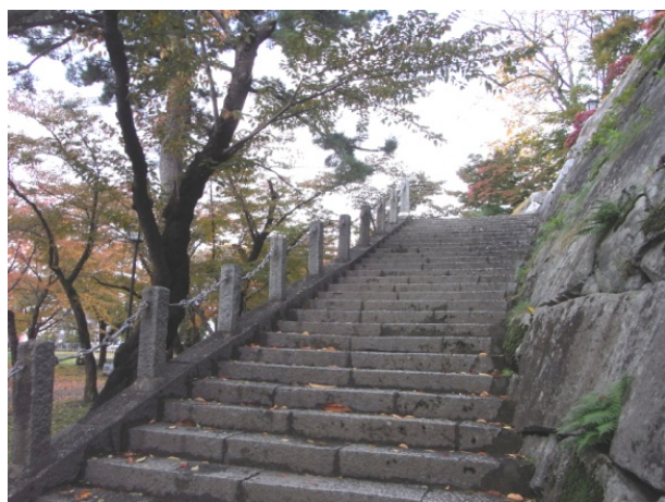
明治期に設置された石段
