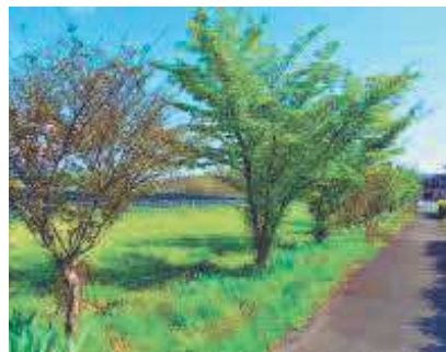
周辺環境を配慮した太陽光発電設備
