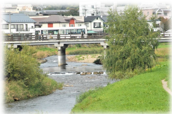
中津川（上の橋）
