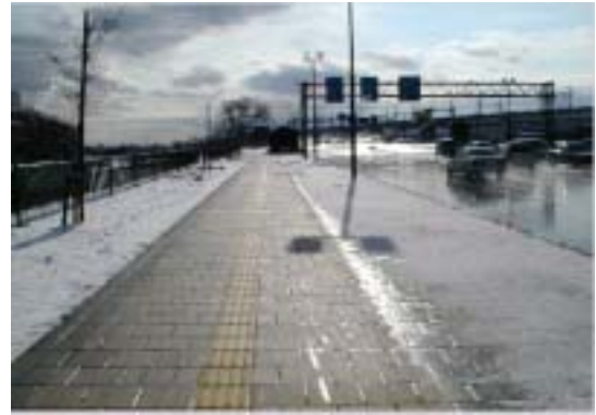
道路・歩道の無散水消融雪(地中熱交換型)
