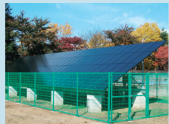
小学校の太陽光パネル
