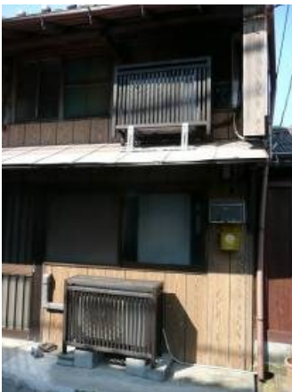
エアコンの室外機を格子で修景した例
