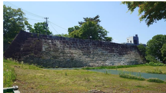
【石垣積上完了（令和6年度）】
