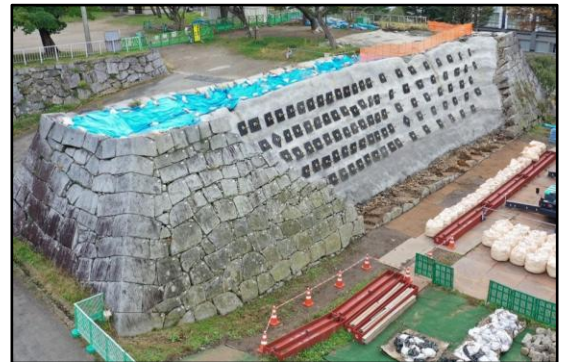
【石垣解体完了（令和4年度末）】
