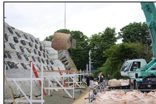
【石垣積み直し作業（令和5年度）】
