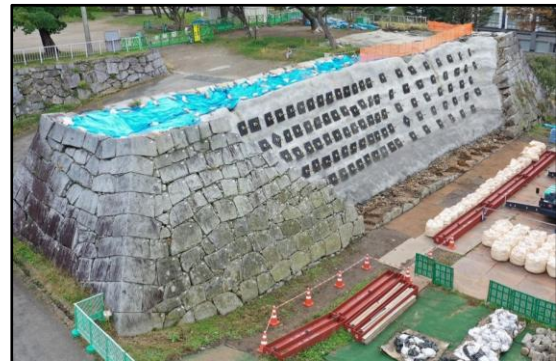
【石垣解体完了（令和4年度末）】
