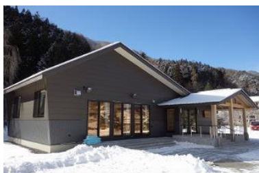
砂子沢生活改善センター(令和3年12月竣工)
