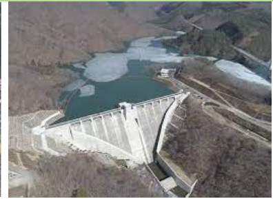
県営築川ダム(令和3年7月完工)
