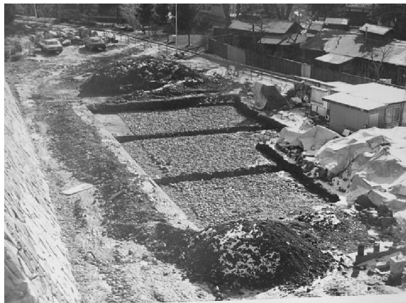
腰曲輪下南部（米内蔵基礎地業確認状況）
