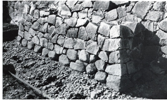
⑱布積C 腰曲輪ハバキ石垣 (撤去前)
