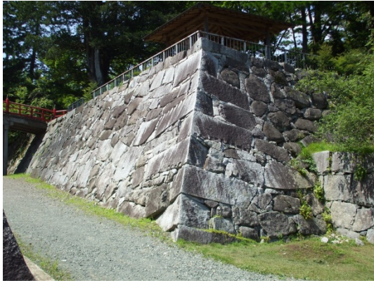
⑨乱積C 二ノ丸南東部（隅部分）
