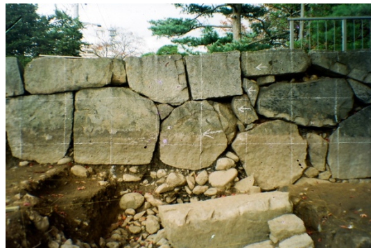
㉒布積E 本丸小納戸櫓台 (撤去前)
