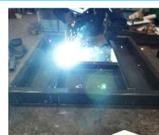
側溝のふた製作 溶接状況
