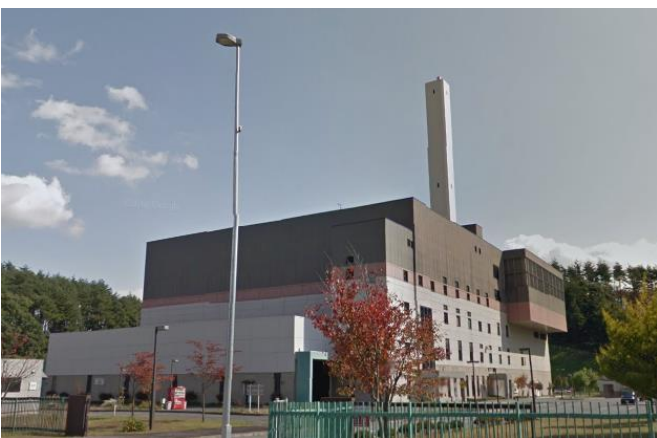
盛岡市クリーンセンター
