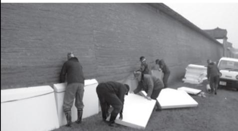
▲凍結防止のため断熱材を設置
