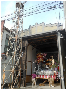
鉾屋町旧消防番屋
