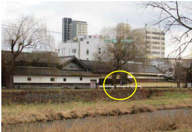
莫蔭九 全体写真(中津川より)
