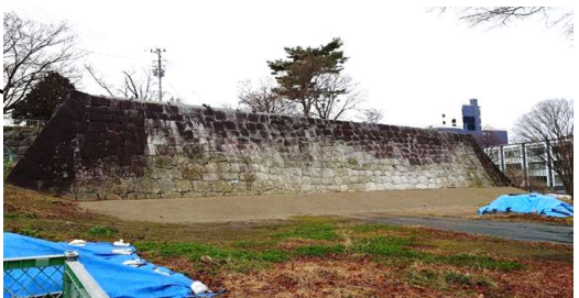
三ノ丸石垣下部盛土工完了
