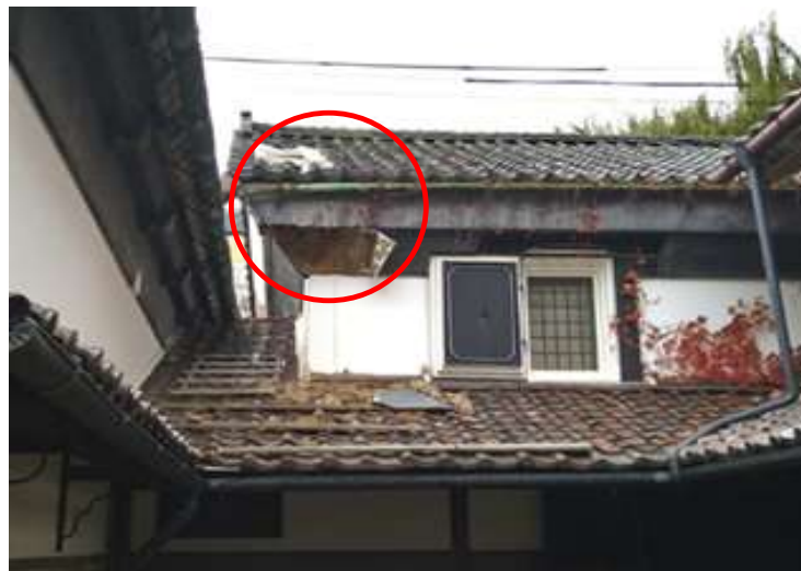
莫産九 葺瓦屋根修繕箇所
