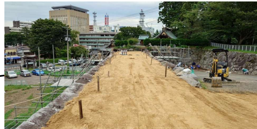
三ノ丸石垣上部盛土工状況
