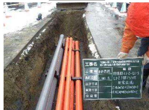
管路部施工状況
